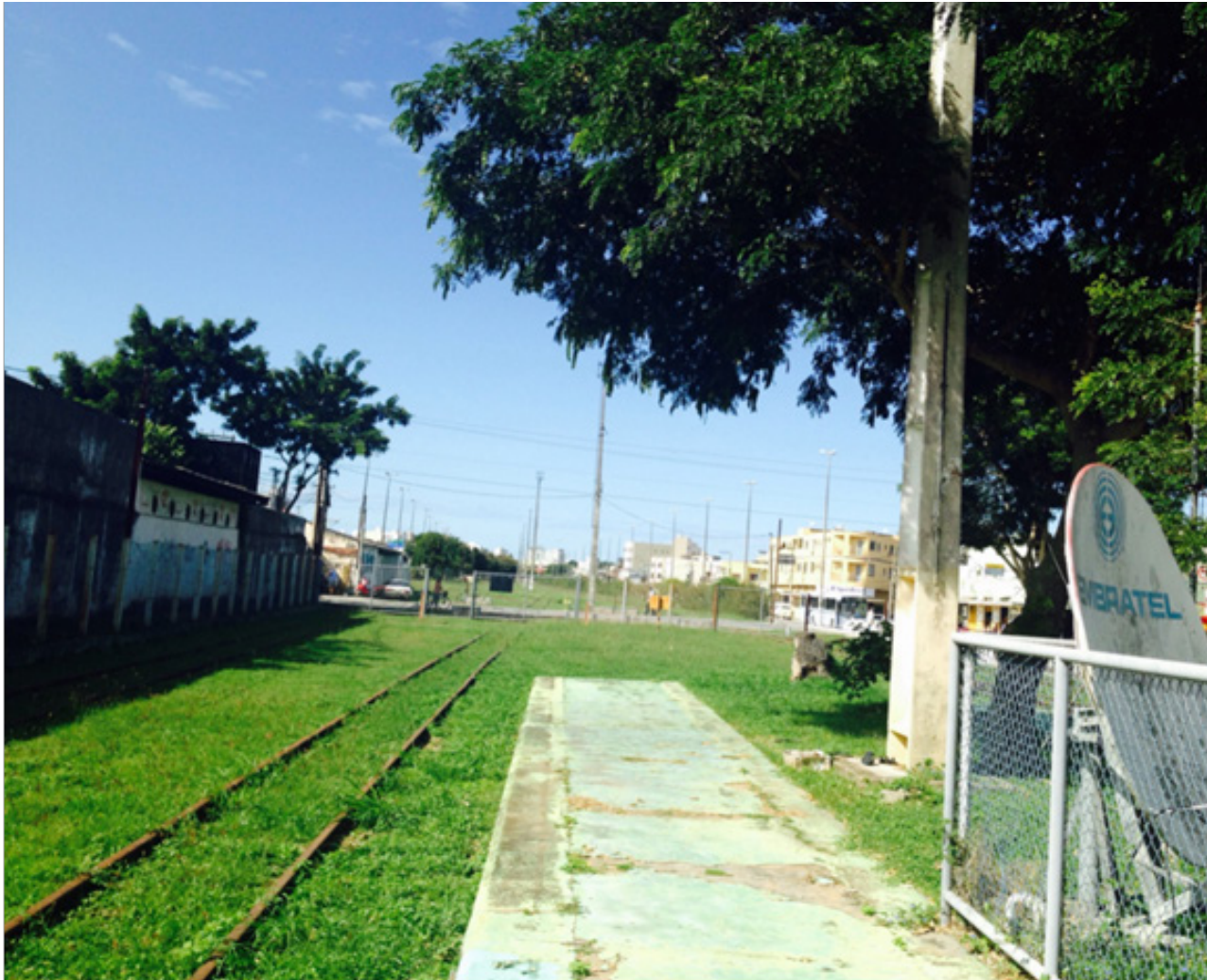
Figura 9.9 - Leito ferroviário desativado em Macaé
